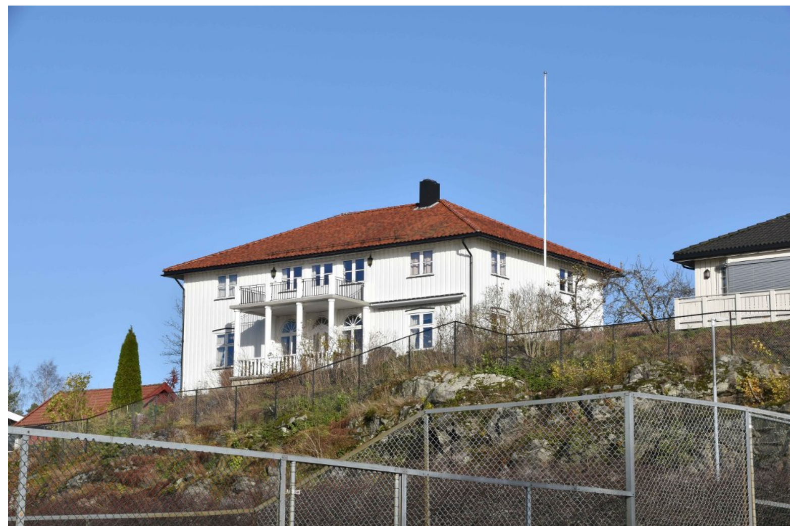
Huset er godt gjenkjennelig i Haresvingen i Våglia. Foto: Gro Arneberg Thoresen
