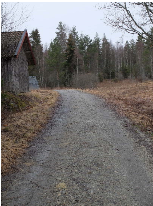
Figur 1-3: Gamle Enebakkveg mellom Durudhøgda og Våg forbi Kvernstua (Bjerkelandsveien) (Historiske vegfar ID 813175) antatt etablert før 1650.
