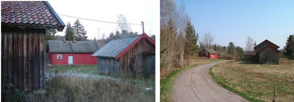
Figur 1-12: Tunet sett fra hhv vest mot øst og sør mot nord. Foto: Asplan Viak 2016.
